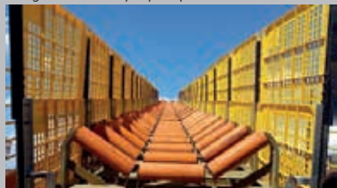
Montagem de correia transportadora
