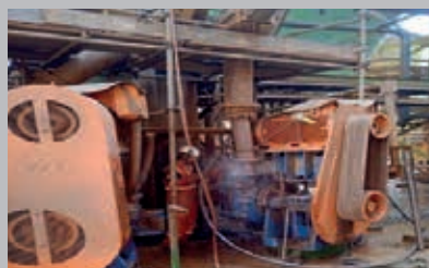
Manutenção de Bombas.
