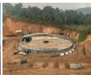
Montagem de caixa australiana
