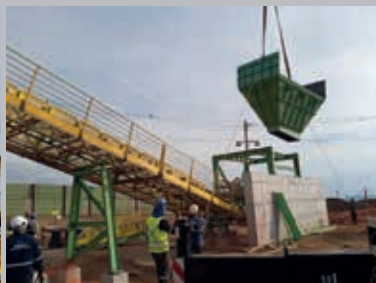
Montagem da Moega de alimentação
