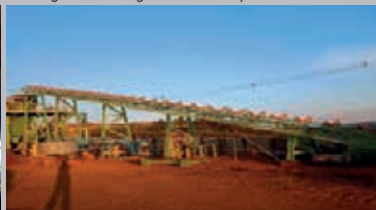
Montagem de correia transportadora
