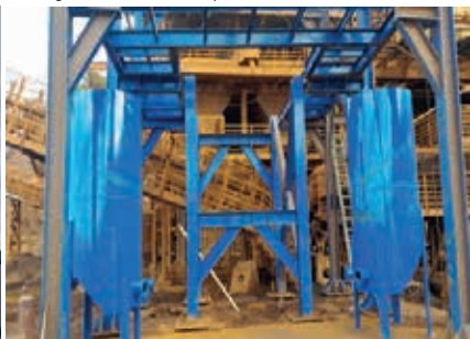
Montagem de estrutura de peneira.
