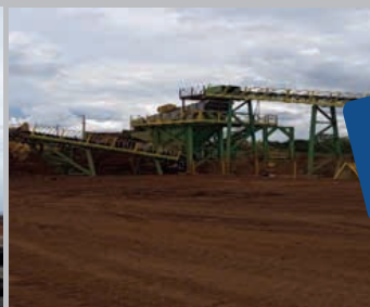
Montagem de estrutura de peneira de Mineração
