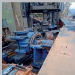
Manutenção de Bombas.
