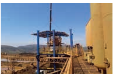
Montagem de estrutura de peneira.
