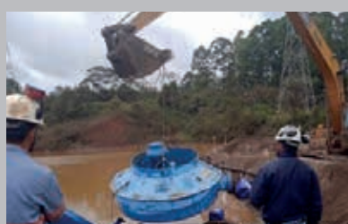
Manutenção de Bombas.
