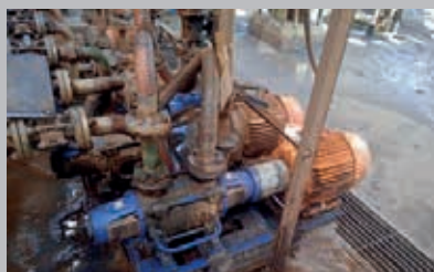
Manutenção de Bombas.
