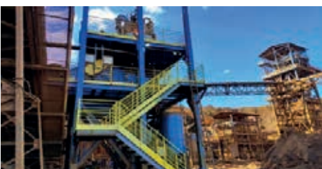
Montagem de estrutura de peneira.
