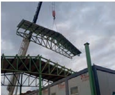
Fabricação e Montagem de estrutura de Galpão.
